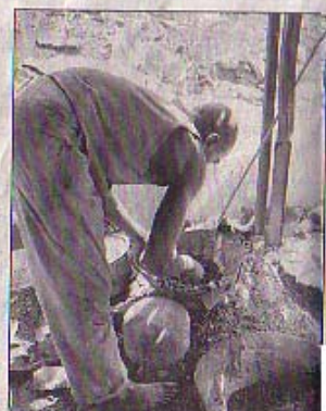
Das Aluminium wird im Feuer geschmolzen und zu Kochtöpfen gegossen. Bild: zyg
